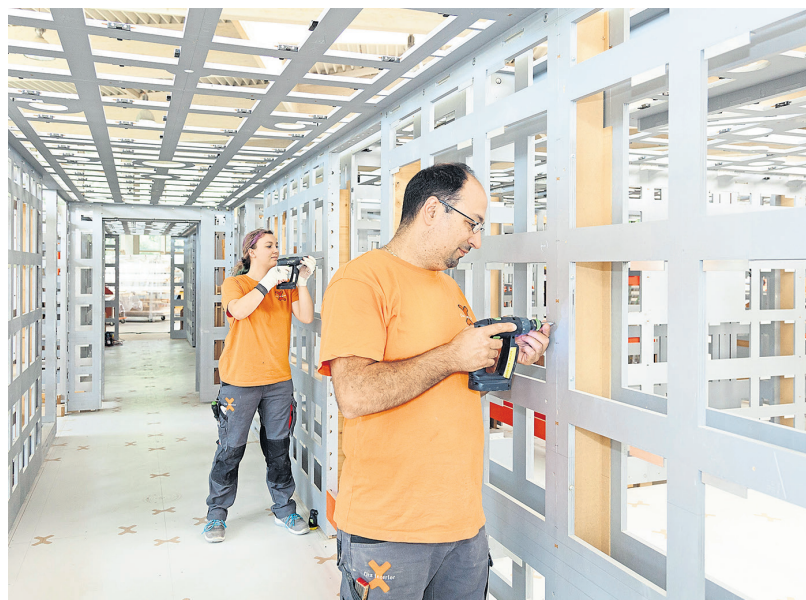
In der Werkshalle werden die Schiffsräume eins zu eins nachgebaut.
